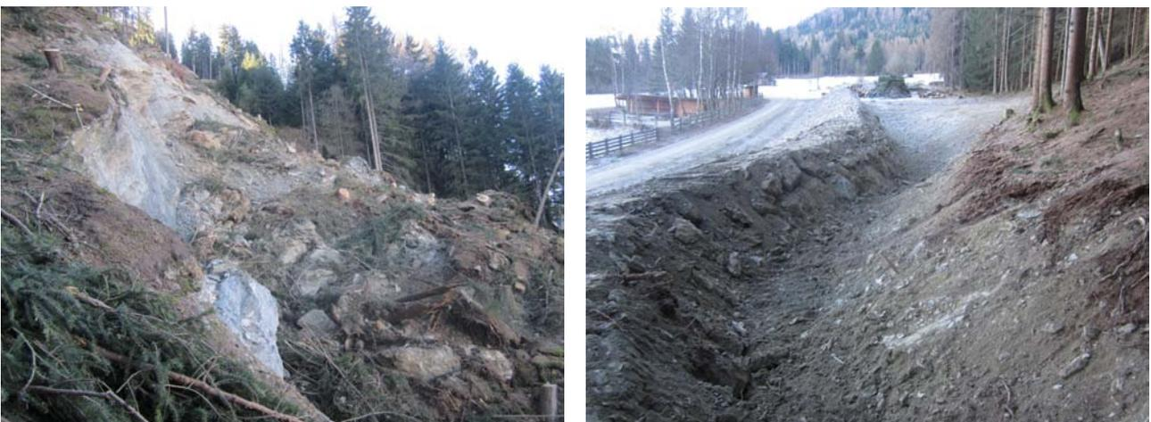
Figura 19: a sinistra la nicchia di distacco dello scivolamento in roccia che ha coinvolto sia la fillade quarzifera che il detrito di versante; a destra uno dei due valli paramassi costruiti al piede del versante, che a febbraio 2017 aveva già intercettato già numerosi blocchi
