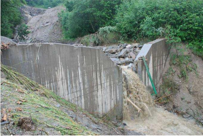
Der Murgang hat beträchtliche Schäden an den jungen Schutzbauten angerichtet. Die durch die Strömung mitgerissenen Zyklopensteine aus den Ufermauern (Foto rechts) erhöhen die Zerstörungskraft des Murgangs.
