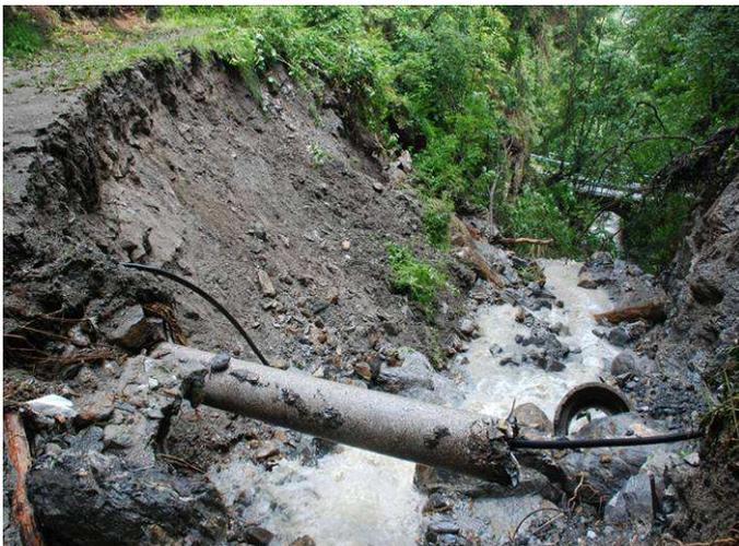
Im Bild links eine durch die Abflusserosion freigelegte Versorgungsleitung
