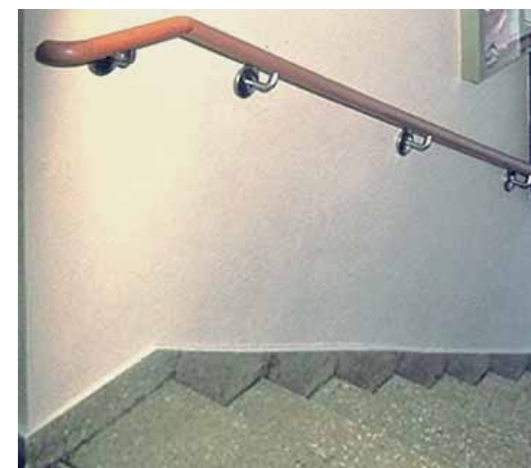
Handlauf: mindestens 30 cm über die Stufen
