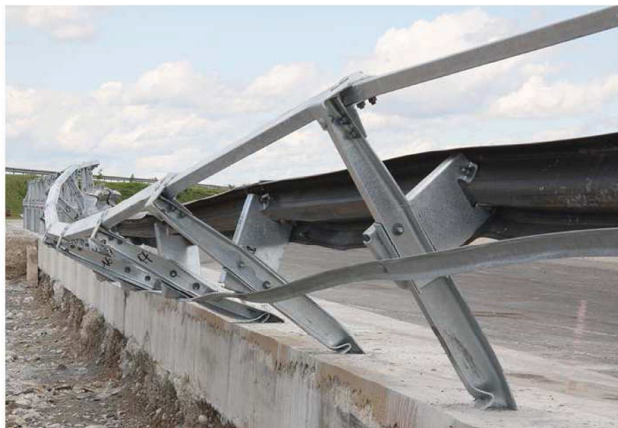
↑ Supports n°16 à 19 / Posts nrs. 16 to 19 / Paletti dal n°16 al 19
