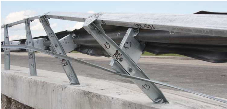
↑ Supports n°10 à 13 / Posts nrs. 10 to 13 / Paletti dal n°10 al 13
