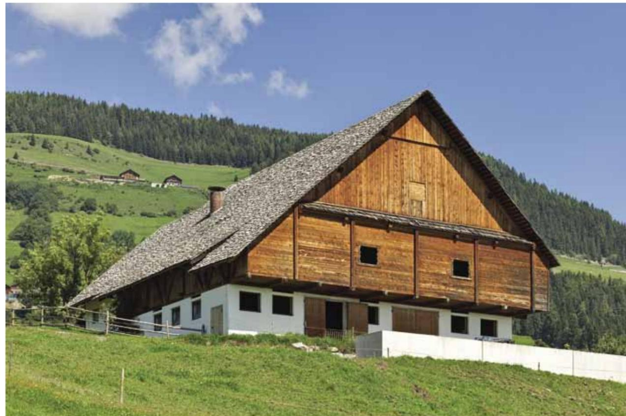
◀ In Typologie, Proportion und Materialien ist der neue Stadel ein Nachbau des barocken Bundwerkstadels. Ein „Industriebau“ hätte die Einheit des Paarhofs unwiederbringlich zerstört. Die moderne Holzkonstruktion ist keine Rekonstruktion, folgt aber dennoch traditionellen handwerklichen Fertigungsmethoden. Das charakteristisch steile Dach wurde wieder mit Holzschindeln gedeckt.
