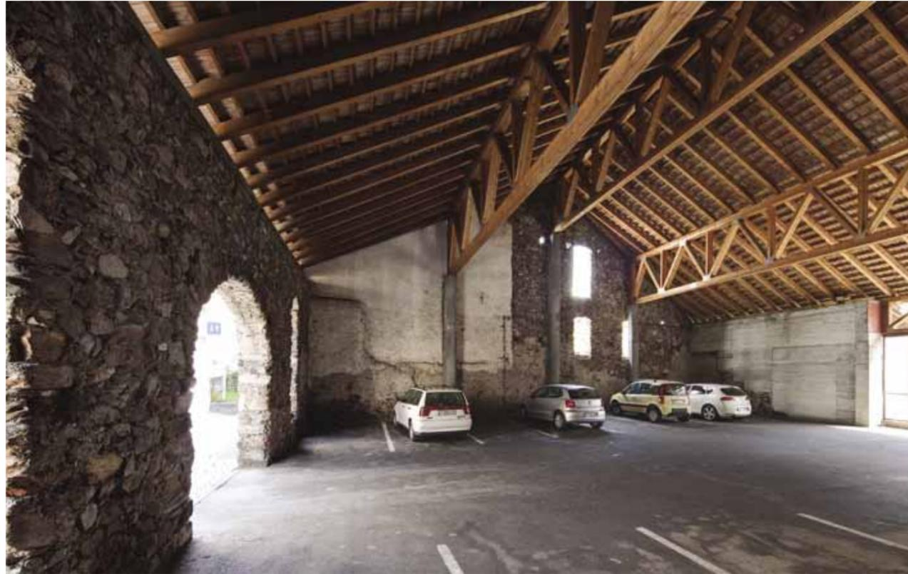
◀ Der Parkplatz im Inneren des Stadels ist stützenfrei mit Nagelbindern überspannt und unverschalt mit Ziegeln eingedeckt.
