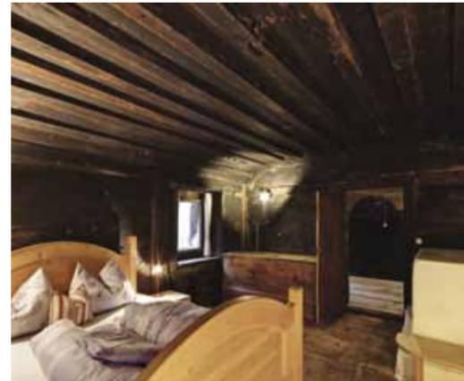
Eine gotische Stube mit gewölbter Bohlenbalkendecke wurde teilweise rekonstruiert. In der Stube mit barocker Felderdecke befindet sich das Fragment einer gotischen Bohlenwand.
