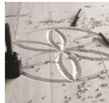
◁ Spartanisch zeigt sich das Interieur, in dem sich nur wenige Möbelstücke und ein offener Kamin befinden. Der gleiche rot eingefärbte Beton des Außenbaus bestimmt auch den Innenraum. 150 Rosetten sind in unregelmäßigen Abständen und in unterschiedlichen Größen über den gesamten Bau verteilt. Jede Einzelne wurde in Handarbeit in die Schalungsbretter geschnitzt.
